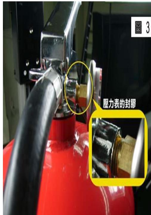
當然很多人會想我隨便打開一下，再鎖回去就會出現標線岔開之現象，何難之有？事實上乾粉滅火器只要打開過，蓄積在滅火器內的壓力會漏掉，一定要重新充填壓力，否則壓力表的指針會歸零。打開滅火器及充填壓力，這兩個動作已是檢驗中最麻煩的步驟，其他諸如檢查乾粉是否結塊、內管有無老化都是輕而易舉的事，負責檢驗的廠商，既然打開了，就會加以檢查，實在沒有必要大費周章將滅火器打開，重新灌氣後，只為了要讓這條線看起來沒有連在一起。
