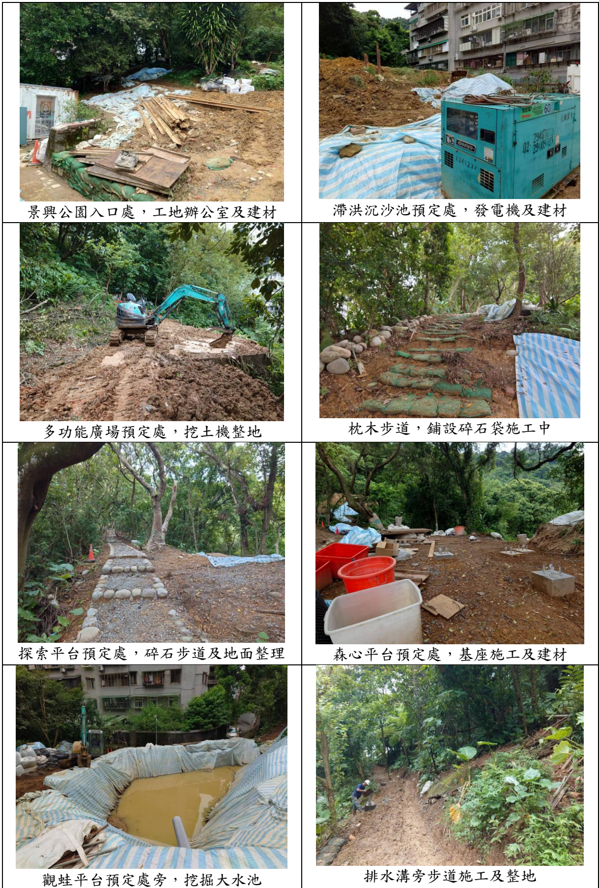
圖4.1-2 施工中棲地影像紀錄。
