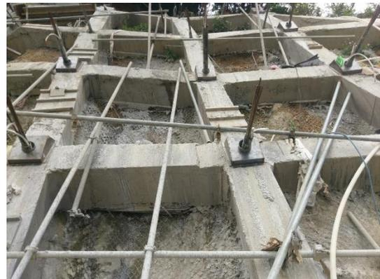
圖 3-14 設置角度調整板
