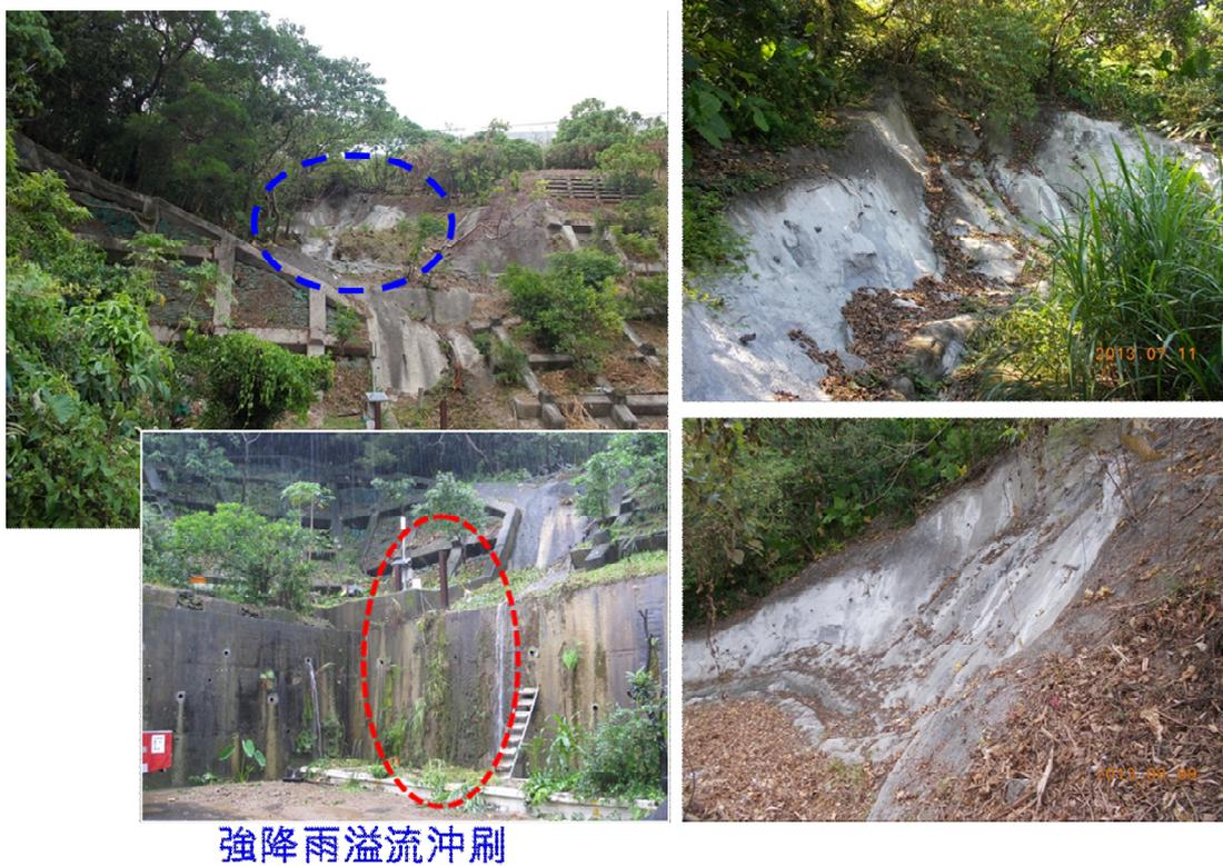
圖 5-7 101 年 6 月 12 日萬芳消防隊後方邊坡坍塌後緊急處置相片
