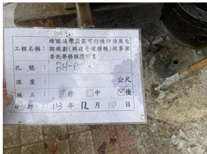
BH-1 鑽孔施工照片(施工後)
