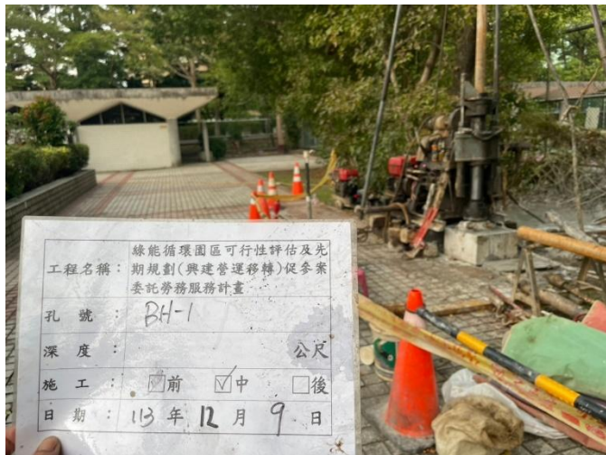
BH-1 鑽孔施工照片(施工中)
