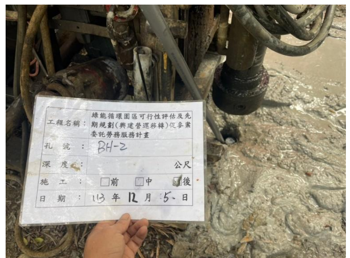
BH-2 鑽孔施工照片(施工後)
