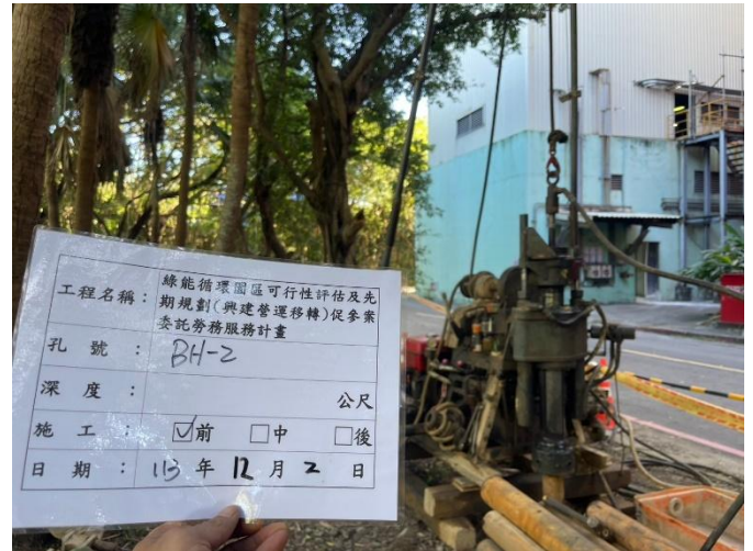
BH-2 鑽孔施工照片(施工前)
