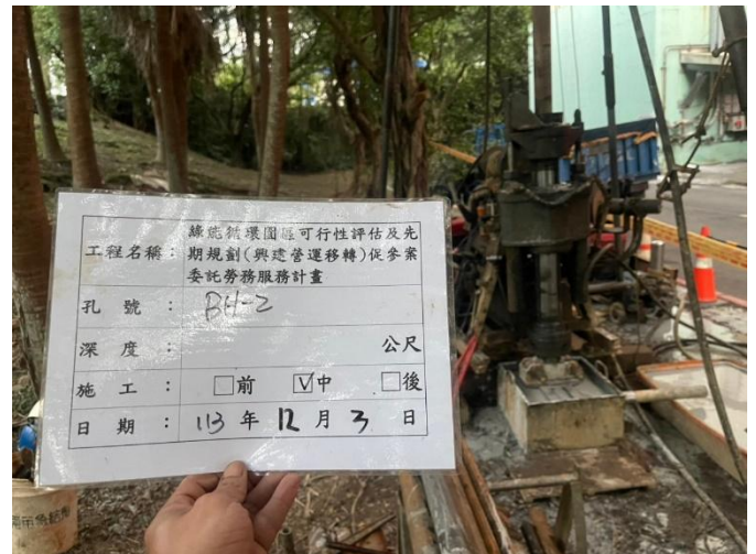
BH-2 鑽孔施工照片(施工中)
