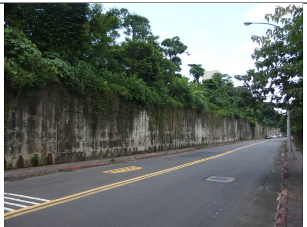
調查點 10: 焚化爐第一階面南側下邊坡現況，植生茂密，現況良好
