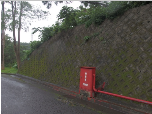
調查點 26: 第三階面邊坡北側擋土牆現況良好
