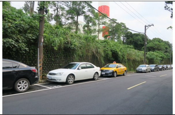
調查點 12: 焚化廠北側道路邊坡保護工，現況良好
