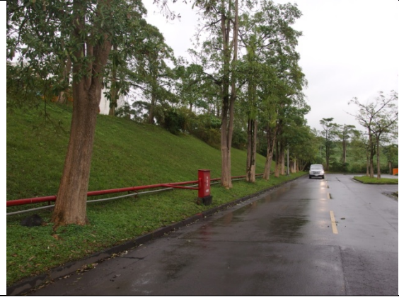
調查點 30: 第二階面邊坡東側邊坡植生茂密，現況良好
