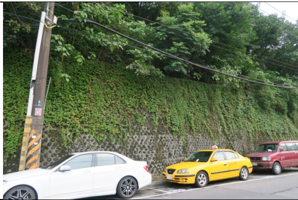
調查點 11: 焚化廠北側道路邊坡保護工，坡面植生覆蓋，現況良好
