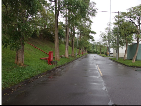
調查點 29: 第二階面邊坡東側邊坡植生茂密，現況良好
