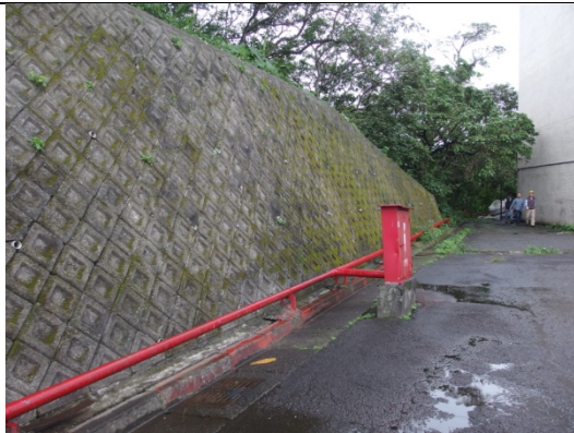
調查點 23: 第三階面東側緊鄰邊坡，擋土牆現況良好
