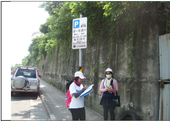
調查點 1: 焚化廠南側道路邊坡保護工全景
