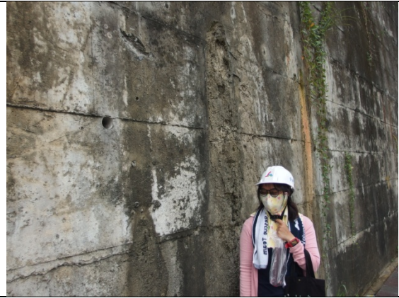
調查點 8: 焚化廠南側道路邊坡保護工現況
