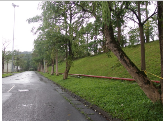
調查點 31: 第二階面南側邊坡植生茂密，現況良好
