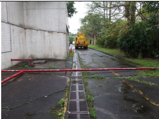
調查點 27: 第三階面建物後方空地現況
