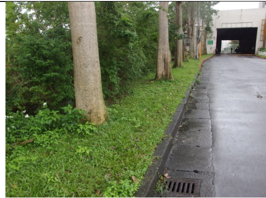
調查點 32: 第二階面南側邊坡植生茂密，現況良好
