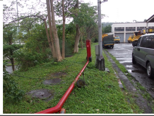
調查點 22: 第三階面南側邊坡植生茂密，現況良好
