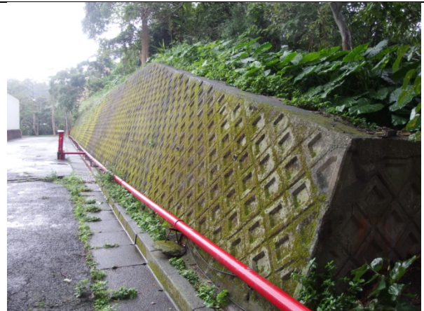
調查點 24: 第三階面東側緊鄰邊坡，擋土牆現況良好
