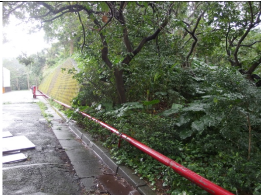
調查點 25: 第三階面邊坡南側擋土牆現況良好
