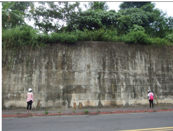
調查點 9: 焚化廠南側道路邊坡保護工全景
