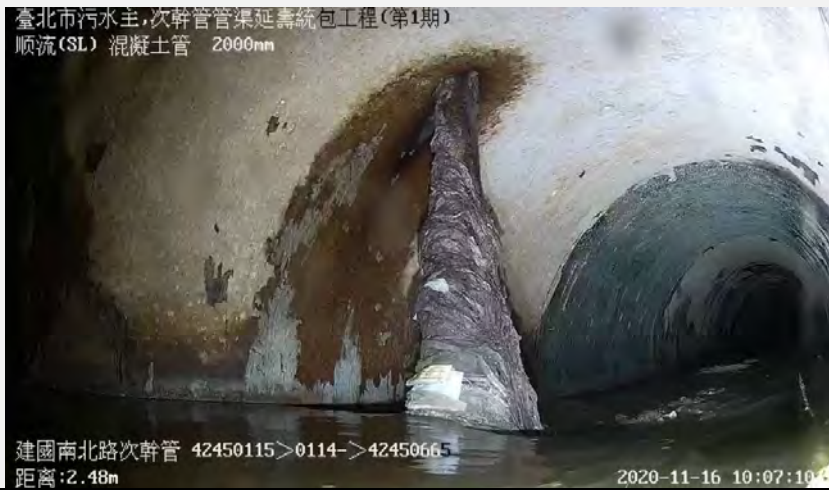
附件圖12：幹管內部修繕
