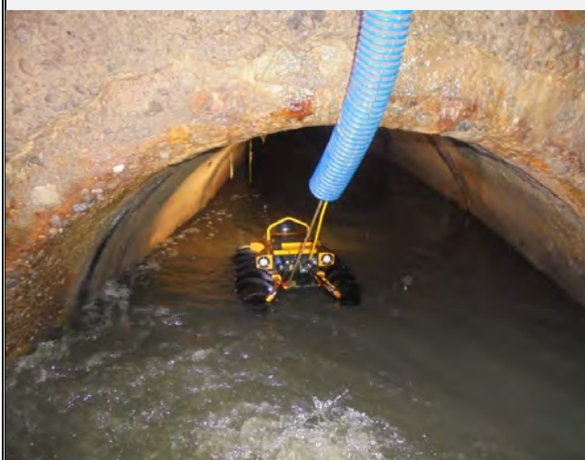
附件圖2：CCTV 及聲納在主、次幹管內檢視實際操作
