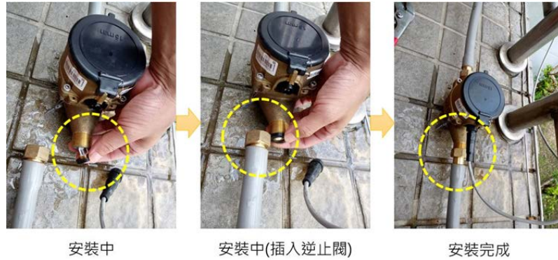
圖10：插入型逆止閥安裝(非破壞性施工、外觀無變化)
