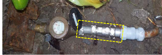
圖6：傳統市售逆止閥施工需裁切管線(困難度高)
