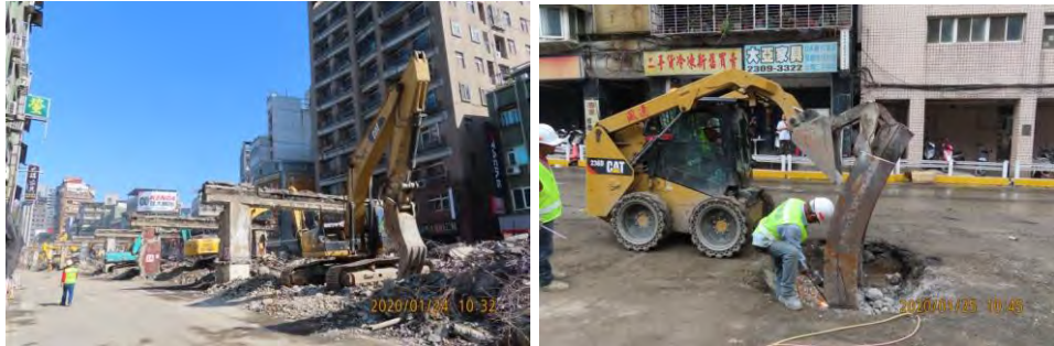
第3階段施工相片(柱基開挖作業)
