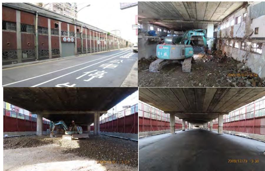
圖2 自強市場之拆除及路基回填施工相片
