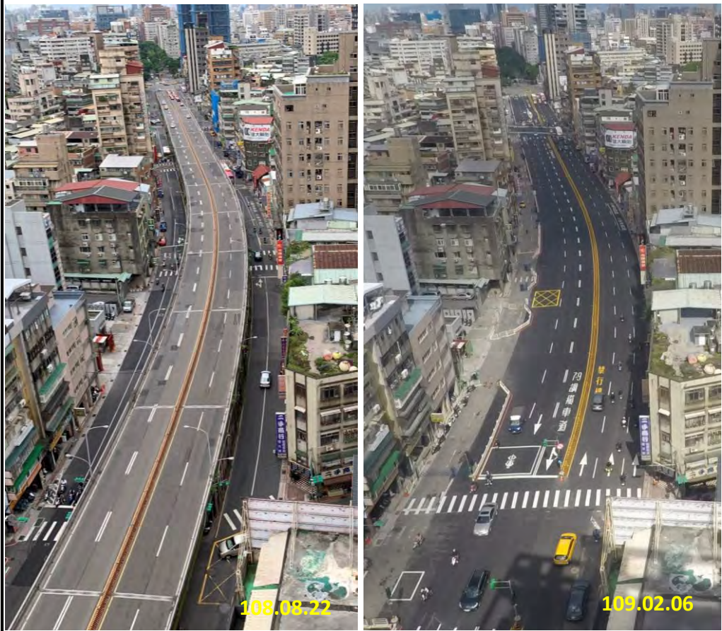
圖1 重慶南路高架橋拆除前後之現況相片
