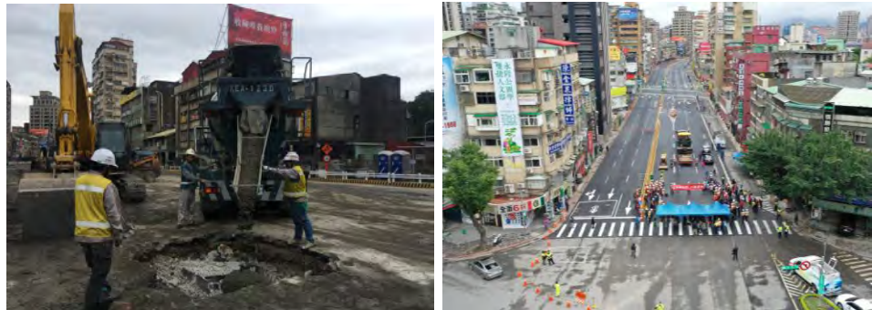
第4階段施工相片(混凝土澆置作業)及通車
