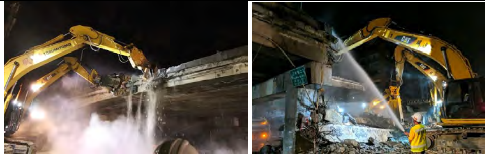
第2階段施工相片(上部結構拆除作業)
