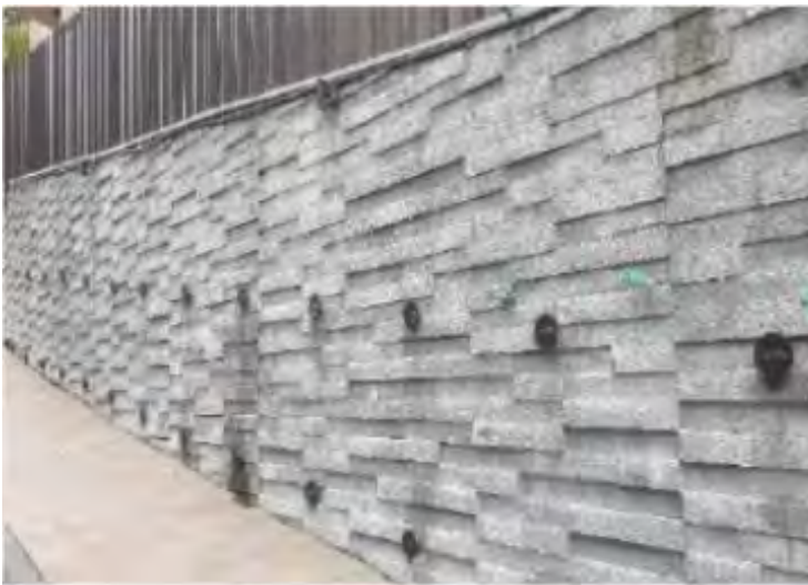
附圖7 擋土牆完工後牆面依需求客製化美化仍保有水保功能
