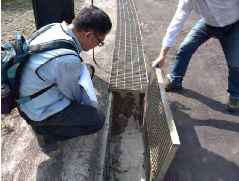
附圖1已完工排水溝檢查維護情形
