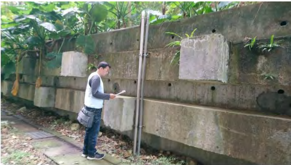
附圖3已完工擋土牆檢查維護情形
