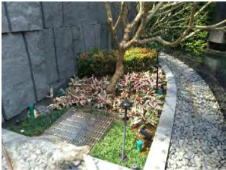
附圖8 滯洪沉砂池完工後依需求植栽造景美化仍保有水保功能
