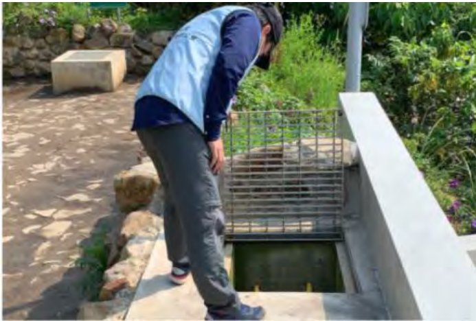
附圖2已完工滯洪沉砂池檢查維護情形
