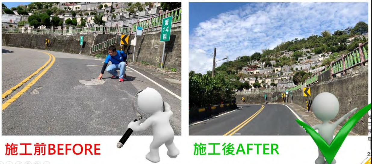
山區道路試辦鋪築冷拌瀝青路基&橡膠瀝青鋪面
