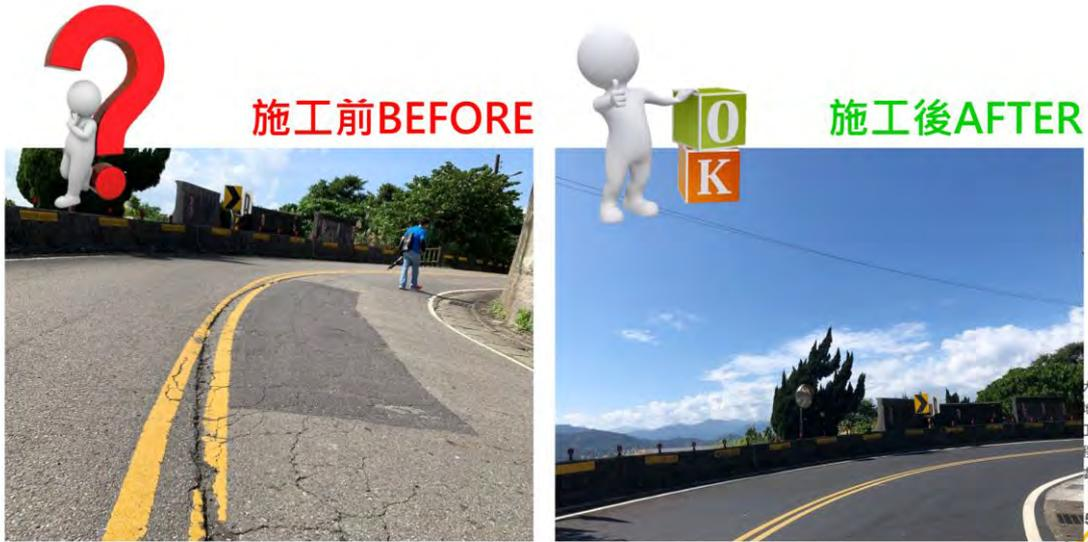
山區道路試辦鋪築冷拌瀝青路基&橡膠瀝青鋪面
