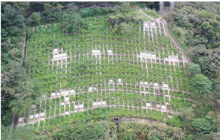
圖2 貓纜 T16塔柱下方地錨邊坡空拍圖
