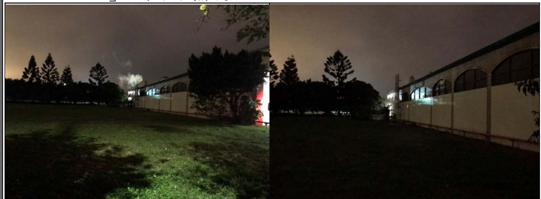
改善前，蒸氣鍋爐排放水蒸氣
