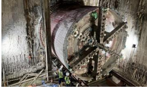
圖 2-潛盾機前移作業
