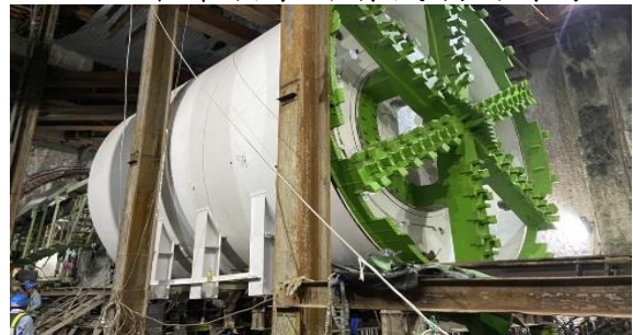
圖 4-潛盾機推進滑移作業
