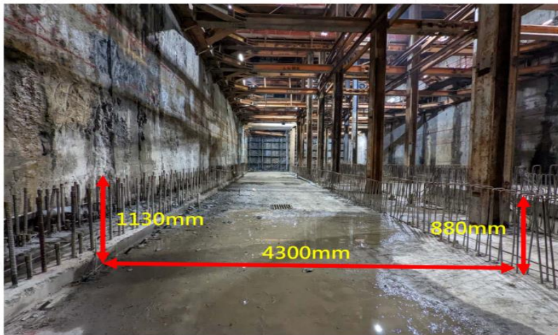
潛盾機通過現場淨寬丈量確認
