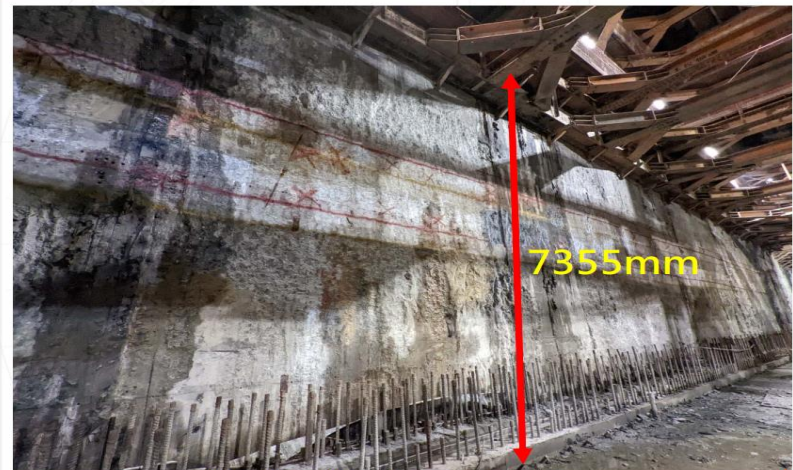
潛盾機通過現場淨高丈量確認
