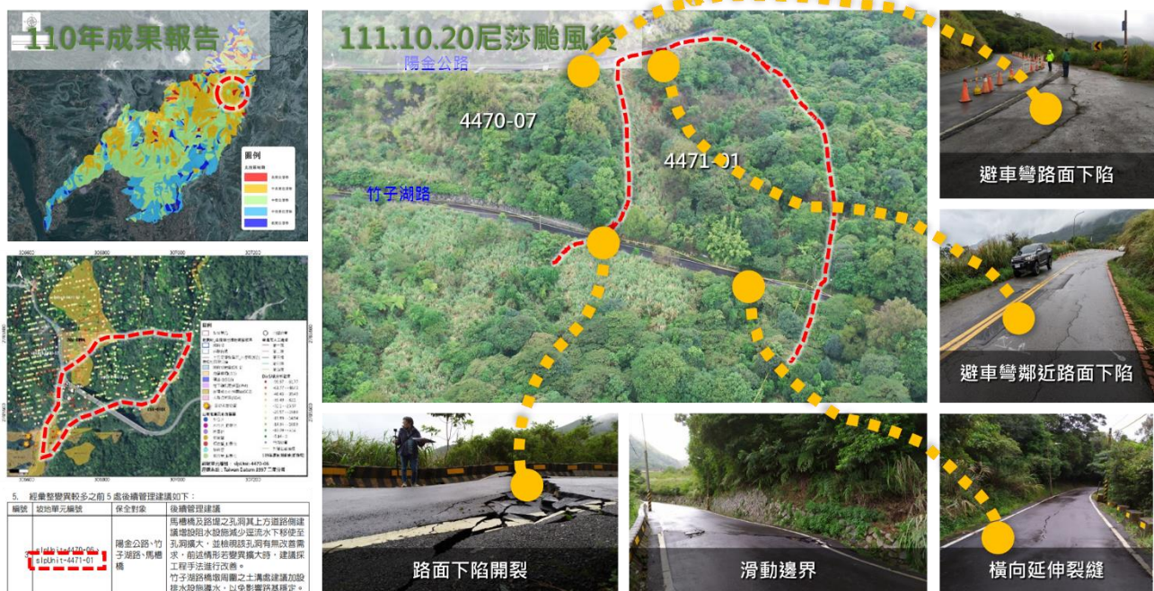
圖10 北投區陽金公路近馬槽橋處成功在尼莎颱風事前偵測潛在山崩
