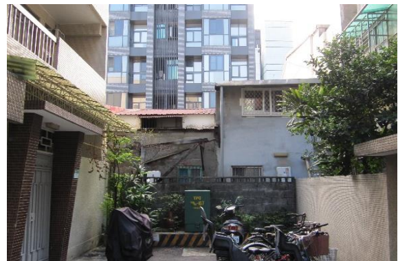
圖 23 中正路 212 巷 7 弄未開闢計畫道路
