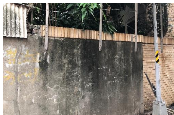
圖 25 中正路 212 巷 10 弄未開闢計畫道路
