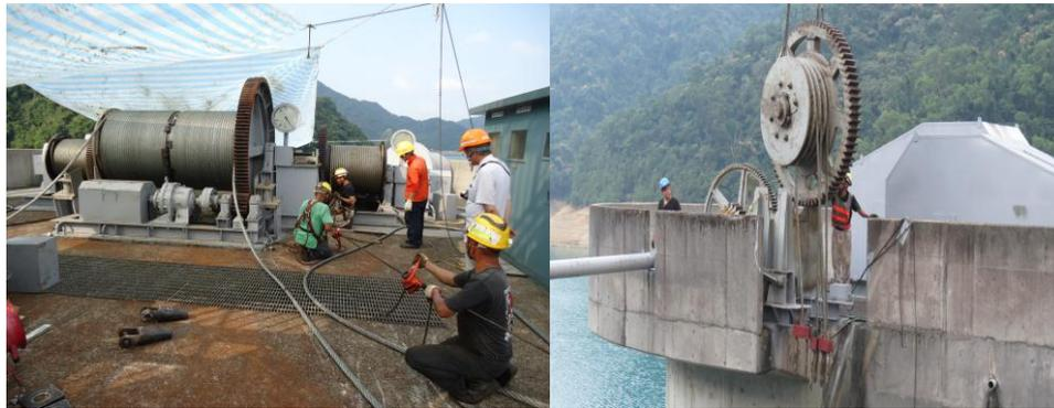
**發電進水口上下游阻水閘門及溢洪道#2、#7 弧型閘門鋼纜更新**
