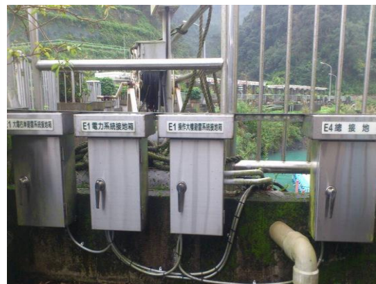
接地網系統接地箱
