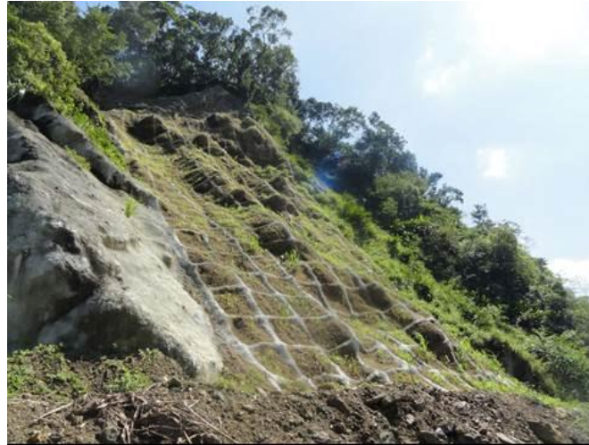
骨材道路裸露邊坡噴凝土型框植生
