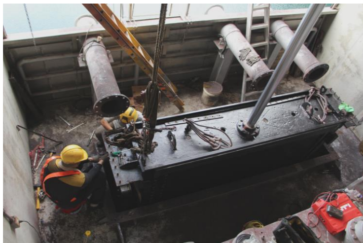
照片 5 翡翠大壩沖刷道閘門大修工作
