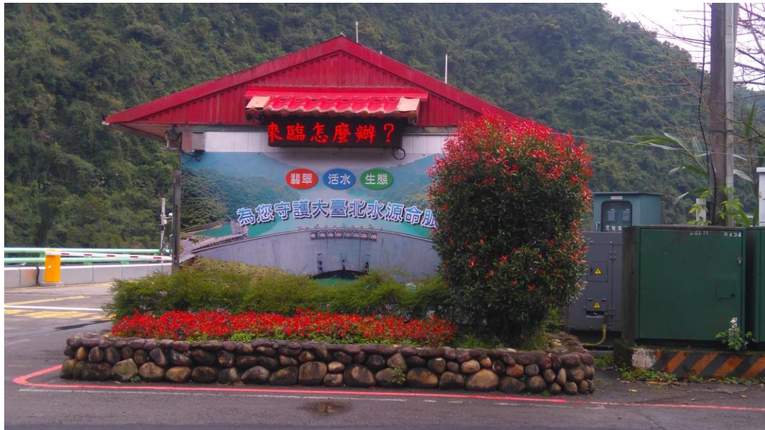
照片 13 一號橋管制站花臺美化情形
