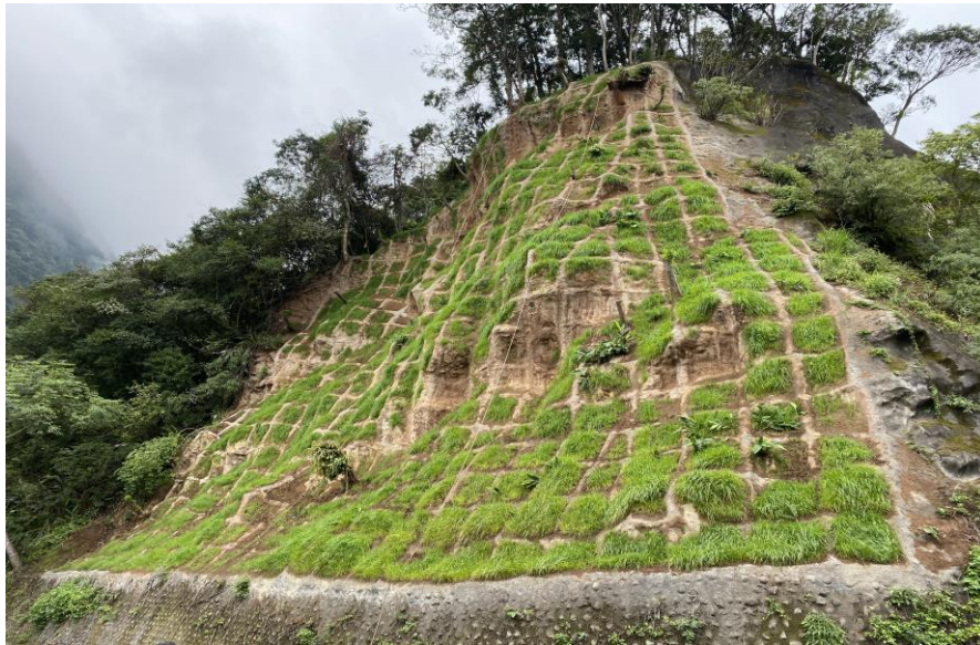
照片 11 骨材道路邊坡坍方整治
