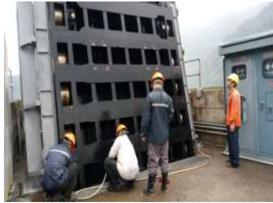
照片 4 沖刷道擋水閘門檢查維護
