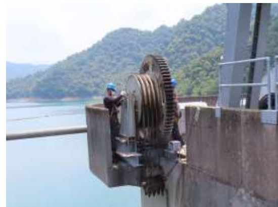
照片 10 溢洪道鋼纜更新
