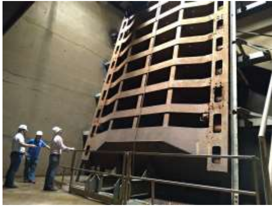
照片 7 發電進水口控制閘門大修
