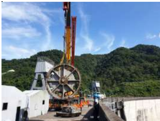
照片 9 溢洪道鋼纜捲筒組吊掛
