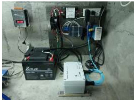
照片 6 強震儀監測設備汰換
