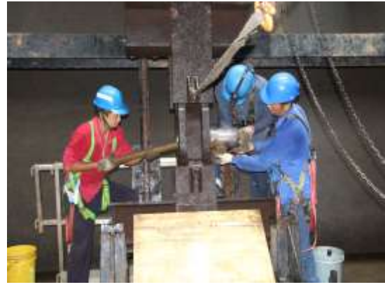
照片 8 控制閘門中間吊桿安裝
