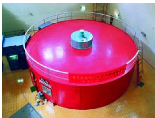
照片 11 翡翠水輪發電機組運轉發電
