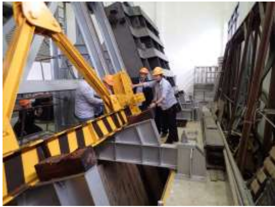
照片 3 排洪隧道擋水閘門檢查維護
