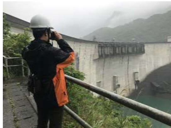
照片 2 大壩現地目視檢查
