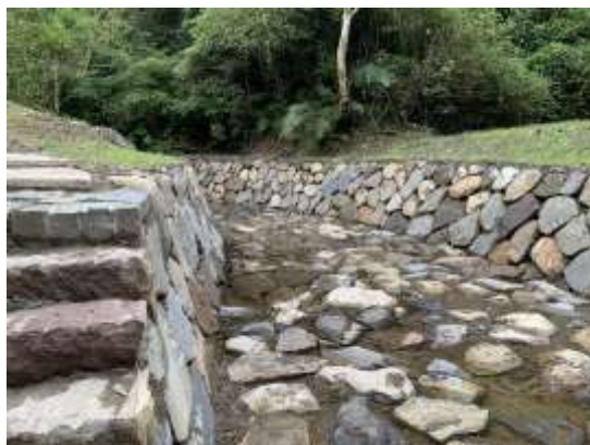
照片 17 完成野溪整治
