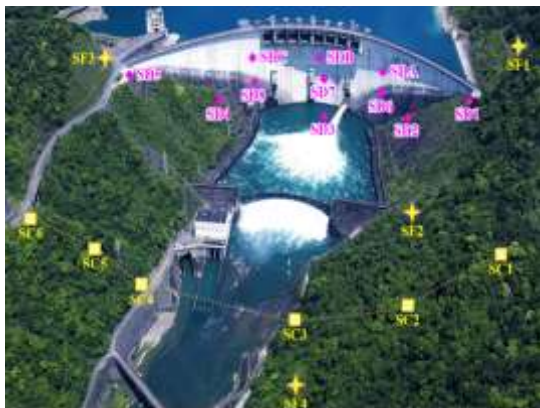
照片 5 大壩及壩區強震儀分佈
