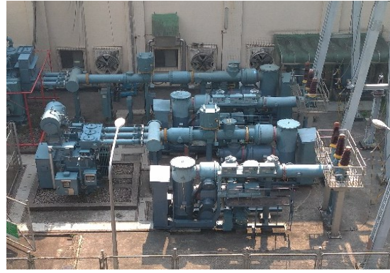
完成翡翠發電機組開關廠匯流排更新
