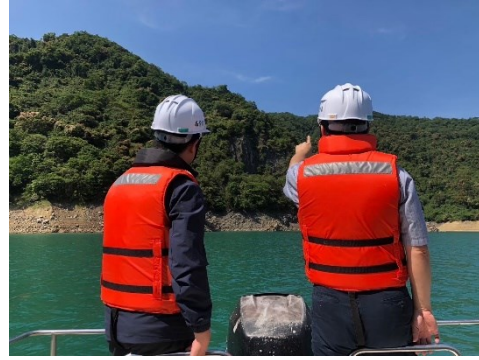
水庫邊坡定期巡檢維護
