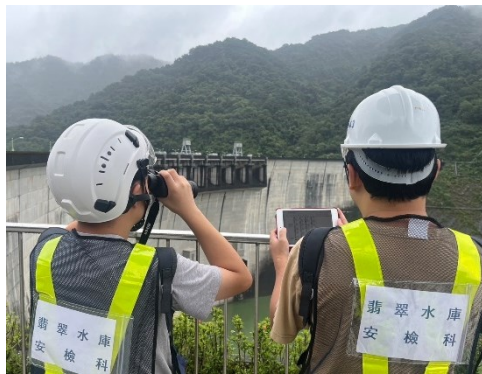
翡翠大壩壩座邊坡巡視檢查
