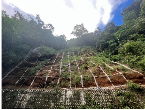
水庫邊坡自由格梁水土保持
