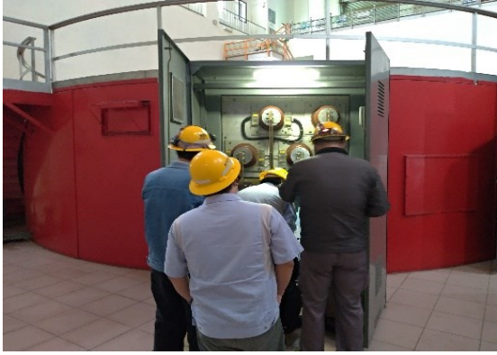
翡翠發電廠進行定期維修
