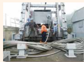
沖刷道鋼纜汰換
