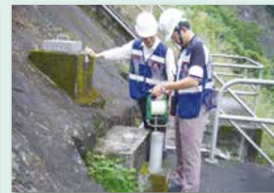
壩座地下水位人工量測
