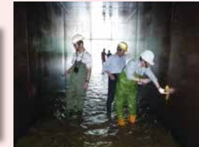
檢查沖刷道鋼襯
