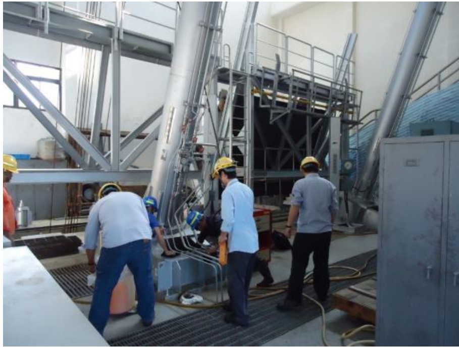
照片 2:105.11.7 排洪隧道控制閘門吊門機維護
