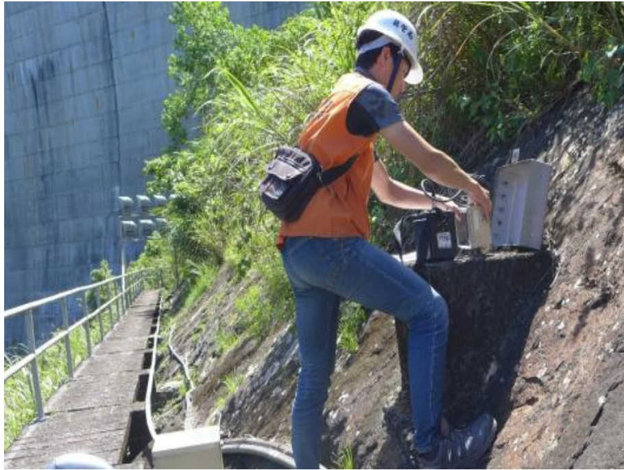
照片 1:105.11.8 執行翡翠大壩安全儀器量測
