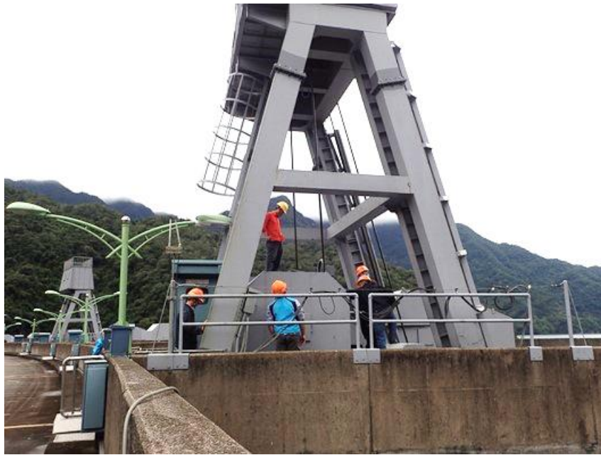
圖 2:冲刷道閘門試操作
