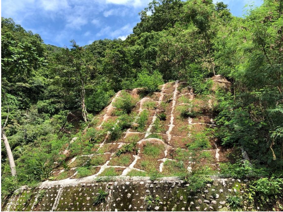
圖 5: 骨材道路邊坡坍方整治
