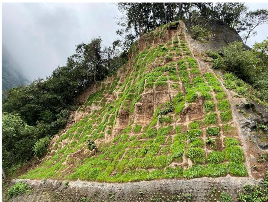
圖 5 骨材路崩塌邊坡整治
