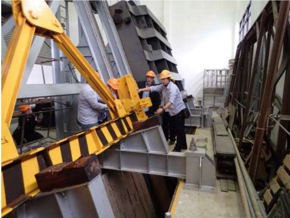
圖 2：排洪隧道擋水閘門檢查維護
