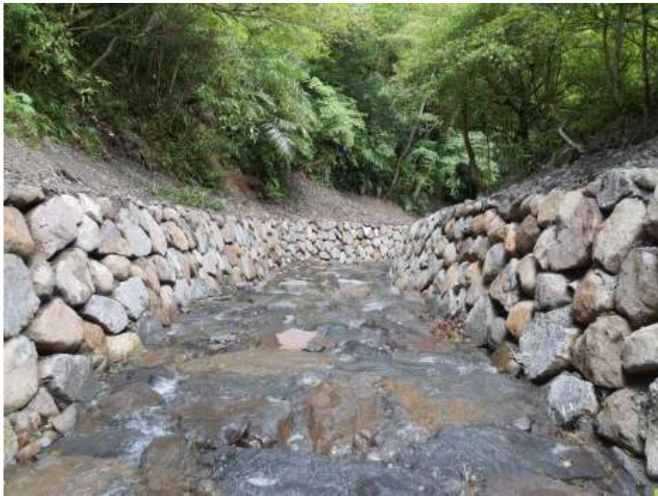
圖 4:水土保持工程溪溝整治
