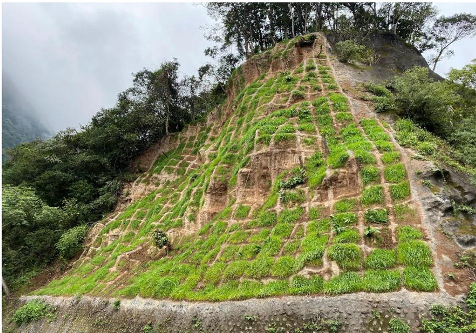
圖 4：骨材道路崩塌邊坡整治
