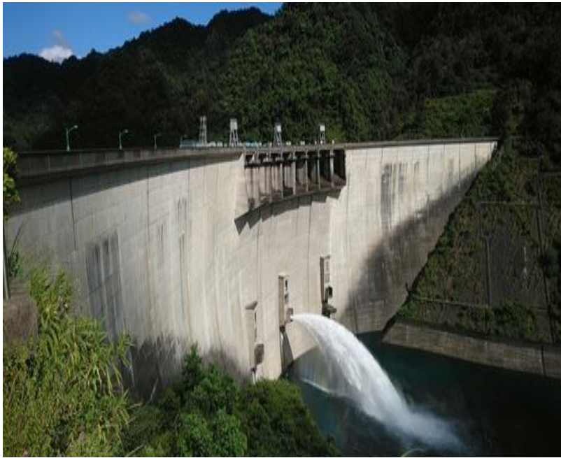
圖 2：水工機械閘門颱風季前試操作
