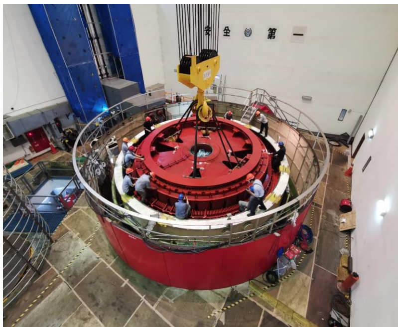
圖 3：發電機轉子拆裝檢修
