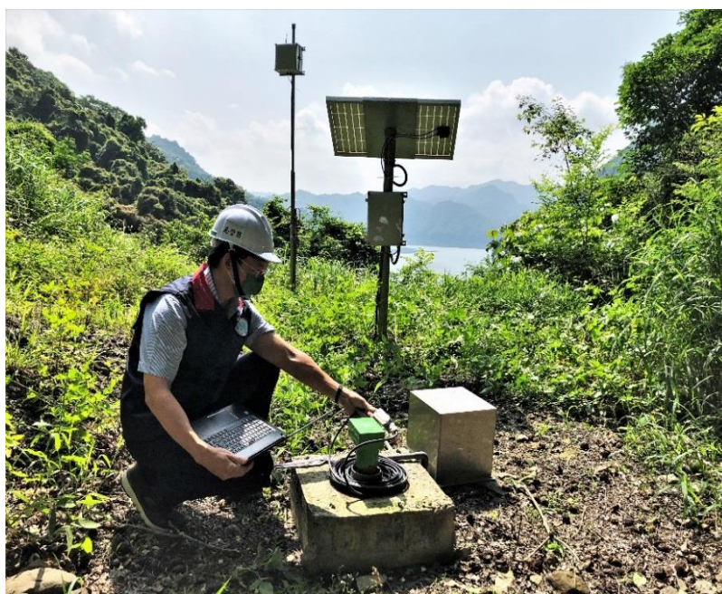
圖 6：高風險邊坡自動監測
