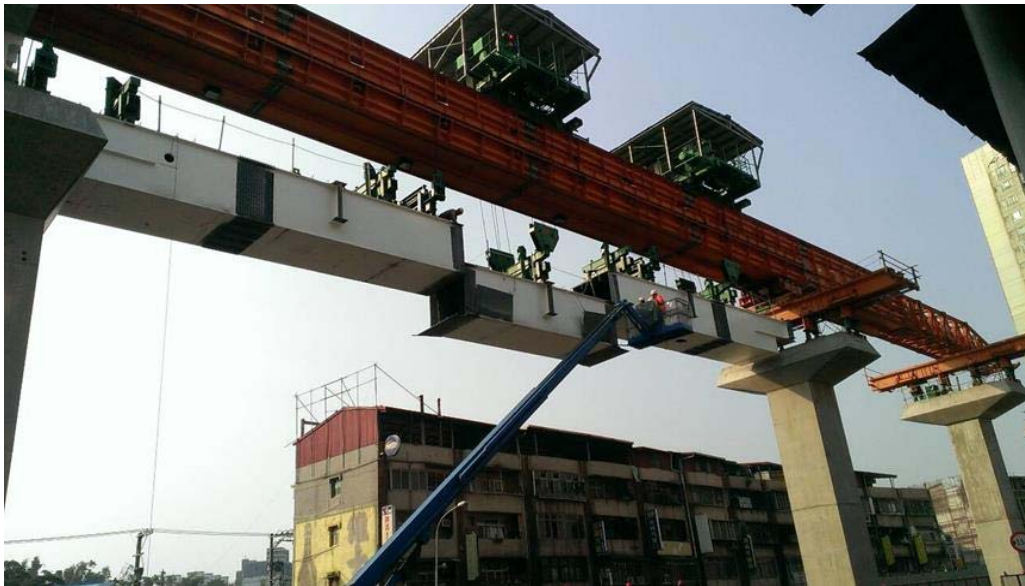
CF651A標工作車吊裝鋼構作業
