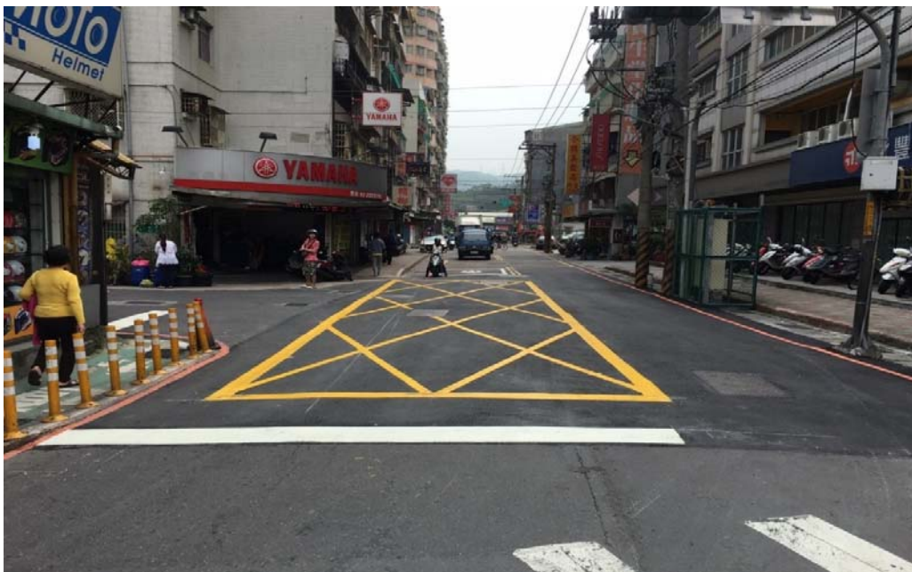
萬大線CQ863子標連城路員山路口改善後現況照片
