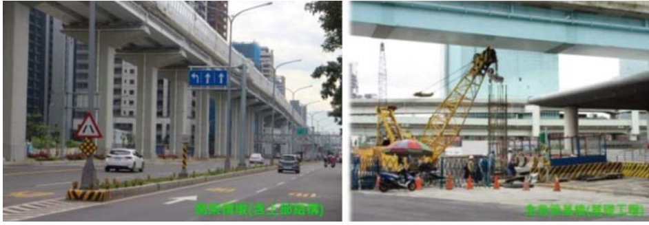
全工區高架橋工程與其全套管基樁工程
