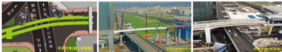
跨越新北大道高架橋吊梁作業(施工前、施工中及完成後)
