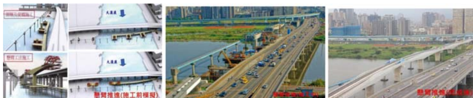
跨大漢溪段工程懸臂推進(施工前、施工中及完成後)
