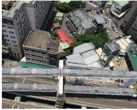
欄梁吊裝完成
