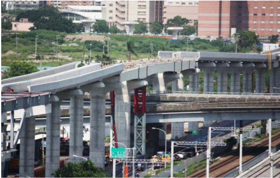
圖10 跨環中鋼構橋樑吊裝圖
