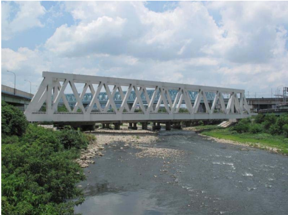
圖8 筏子溪鋼桁架橋
