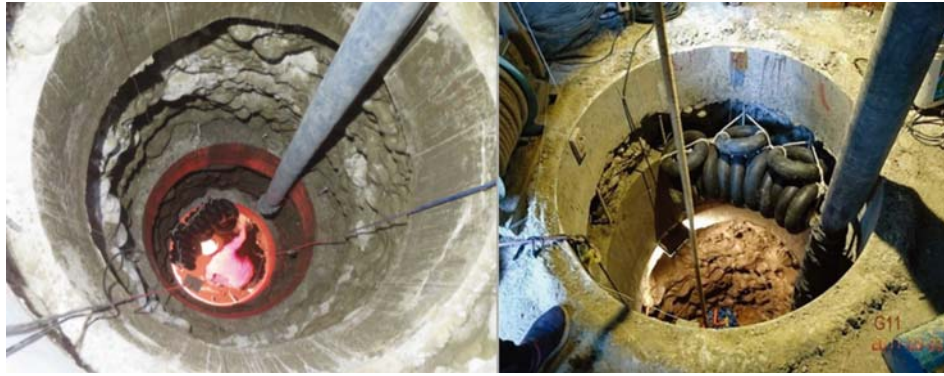
圖16 人工擋土柱施工圖
