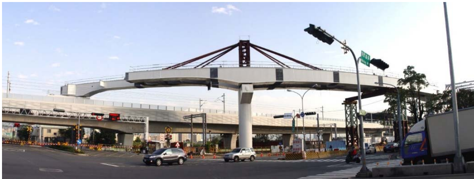
圖9 跨臺鐵鋼箱梁吊裝圖
