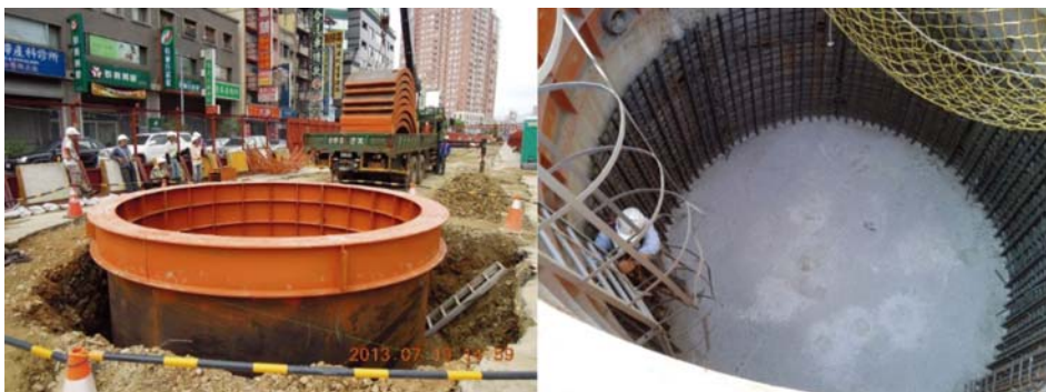
圖13 井式基礎工法施作圖
