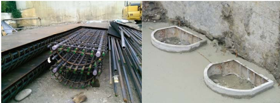
圖15 半圓形人工擋土柱鋼筋籠及完成狀況
