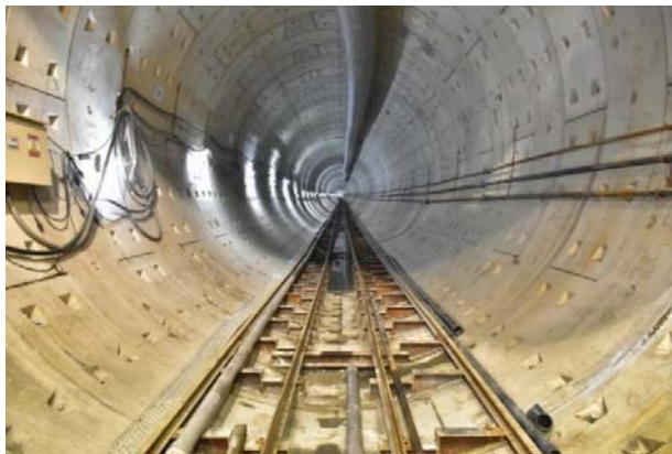
已完成隧道施工品質良好，無滲漏水情形
