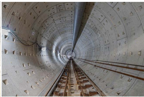
已完成隧道施工品質良好，無滲漏水情形
