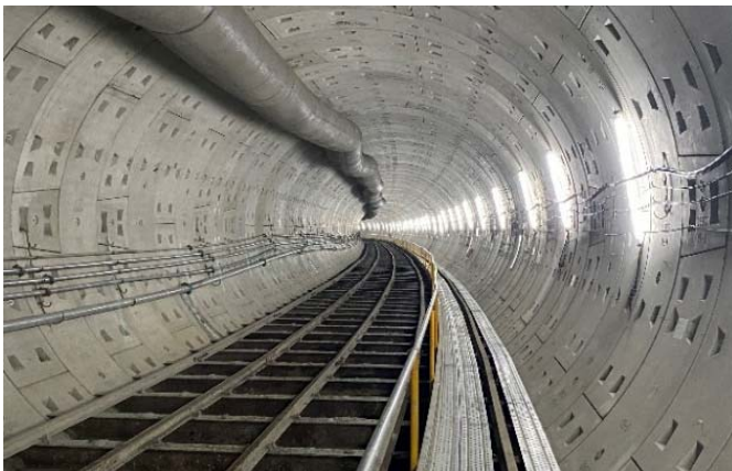
隧道混凝土環片組立完成
