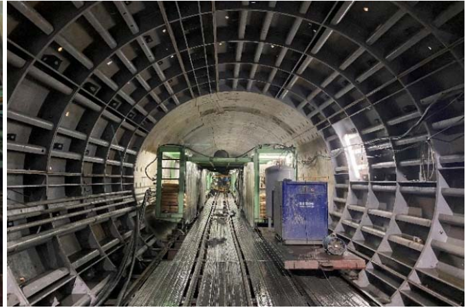
隧道鑽掘作業狀況
