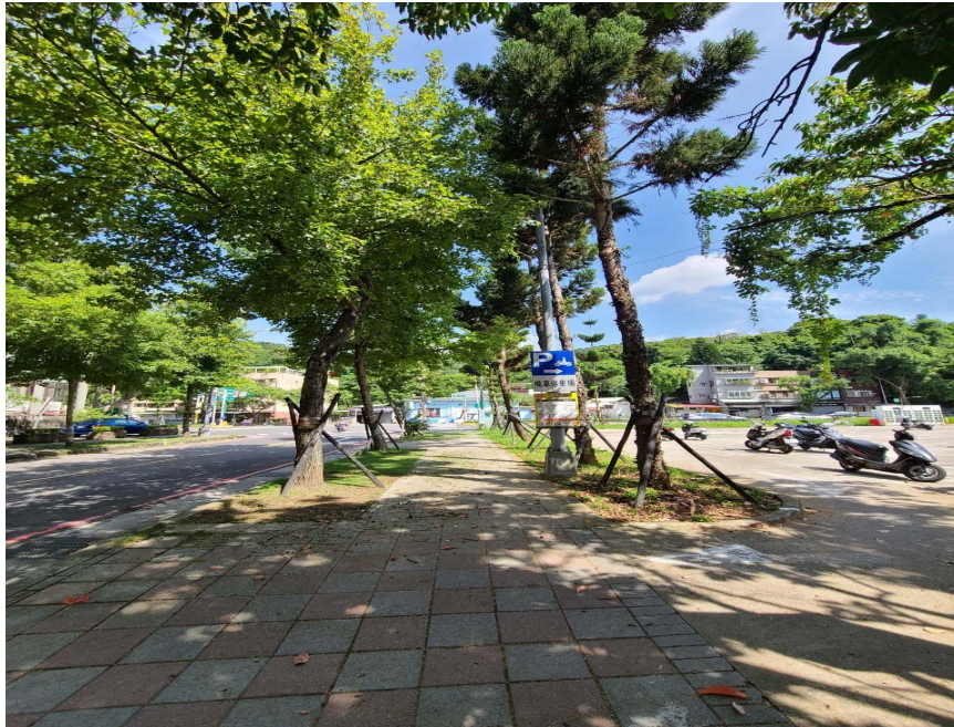
圖一、至善路二段及力行街口施工照片
