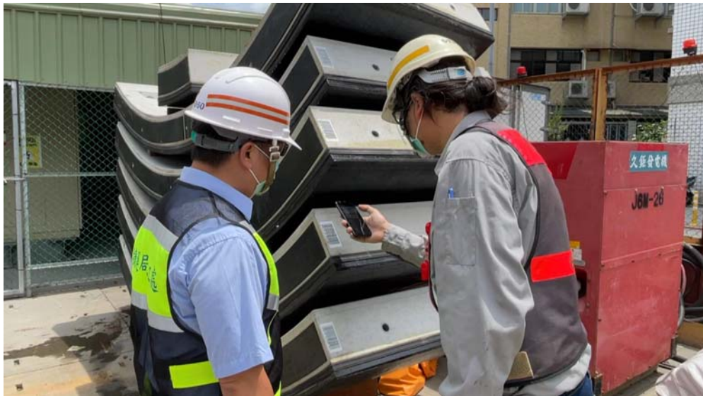
預鑄混凝土環片工地品質檢驗
