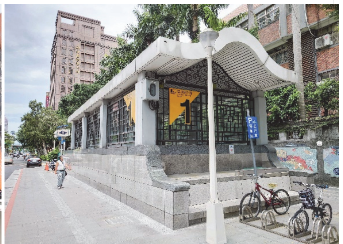
圖4:忠孝新站1號出入口雙向電扶梯啟用
