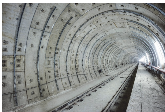
圖四、捷運潛盾隧道
