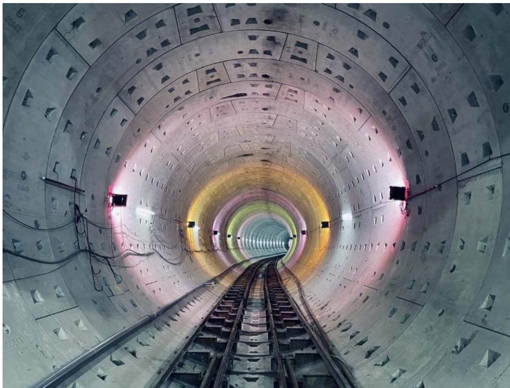
潛盾隧道半徑260公尺轉彎弧度
