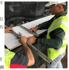
結構,可抵擋強風形成的正負壓,是近代工業上玻璃技術的一大突破,經濟且具有藝術視覺美感的新技術材料。為了滿足臺灣的綠建築,膠合內夾層XIR膜可有效過濾太陽的紫外線,卻不妨礙視線的穿透性,安裝樓板懸挑出去之鋼構台座,玻璃下端坐落支撐墊塊上,上方的固定僅在防止玻璃前後傾倒,但仍然留有空間容許玻璃在地震力作用時有些許的位移活動空間,以避免應力集中造成的碰撞,施工期間相鄰波浪玻璃收邊處裡的2,485片鋁質外飾板,其生產是非常困難的工作,因應波浪玻璃生產的曲線誤差,外飾板生產前要精確量測波浪玻璃形狀尺寸,經過打板、加工生產、手工作業,甚是繁瑣費時,所幸經廠商的努力不懈,終於順利完竣。
