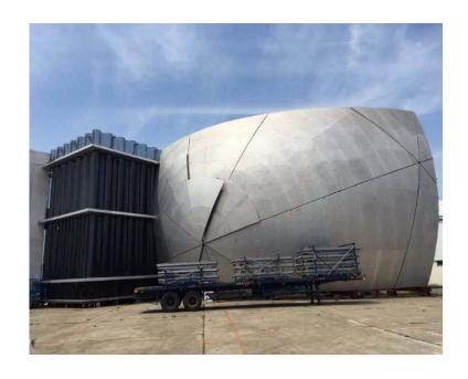
面對南向的大劇院和北向藍盒子劇場,同樣位在4樓。這兩個各自獨立的劇場在立面的材料以類似的工法處理,暗示著兩個劇場內部有間接關連性。採用0.3公分厚的CNS5083平面鋁板,以手工打磨的方式去除其光滑亮面,利用創造漫射光源的平光效果而緩和環境的背景,視覺具有工匠處理的手工質感,使得量體視覺上不會因為超長尺寸10.85公尺而顯得龐大單調,反而在不同天氣和光源下,立面的局部都有各自不同的展現,異中求同的趣味效果。其表面處理是將鋁板以80號和120號砂紙在工廠以雙向研磨的方式去除表面金屬膜,其手工研磨的質感使得每片鋁板看似相似卻又有獨特的花紋,創造出均勻又富生氣的紋路,使得大面積分割的平板表面,有著不遜色於弧形鋁板的生動表情。CNS5083鋁板雖然有著極為優良的抗氧化性,但當表面在研磨處理完成,表面毛細孔打開的狀態若接觸到水漬和髒污,則會被吸收到毛細
