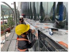
為了創造出中央方形量體劇場不同層次且具透明感的趣味的光影效果,臺北藝術中心的外牆採用了類似於2005年興建完成的波爾圖音樂廳的主視覺牆面-弧形波浪玻璃外牆系統。S型波浪玻璃為結構玻璃的一種,選用8mm+8mm、
