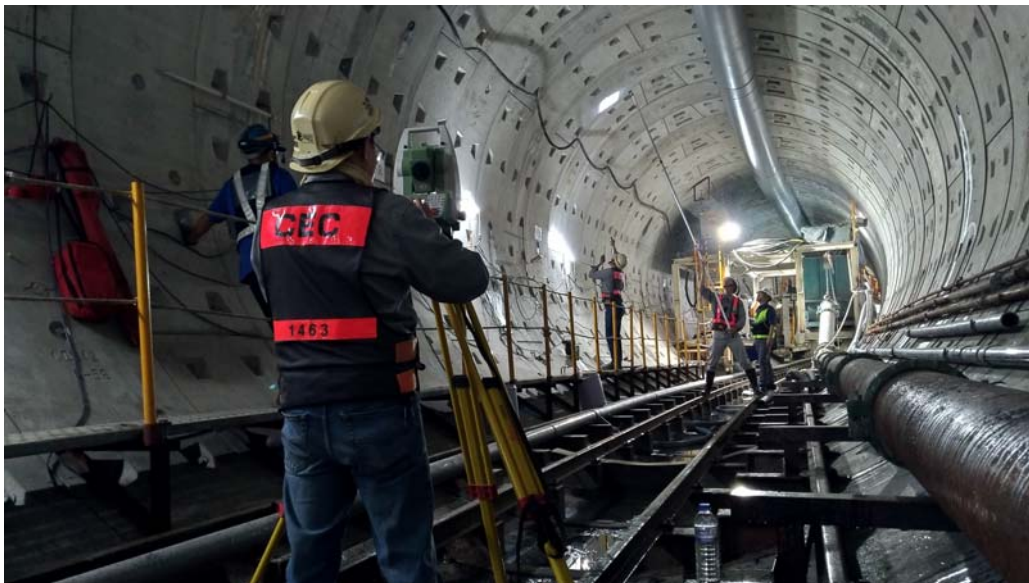
捷運工程測量工程師於潛盾隧道檢測
