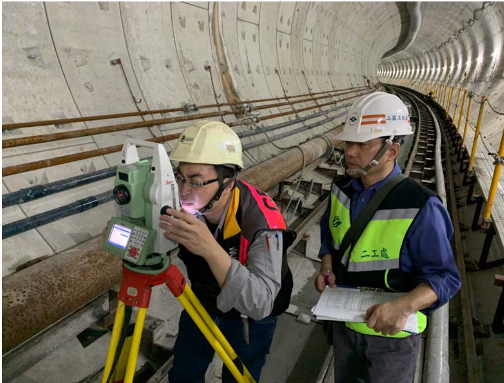
捷運工程測量工程師於潛盾隧道檢測
