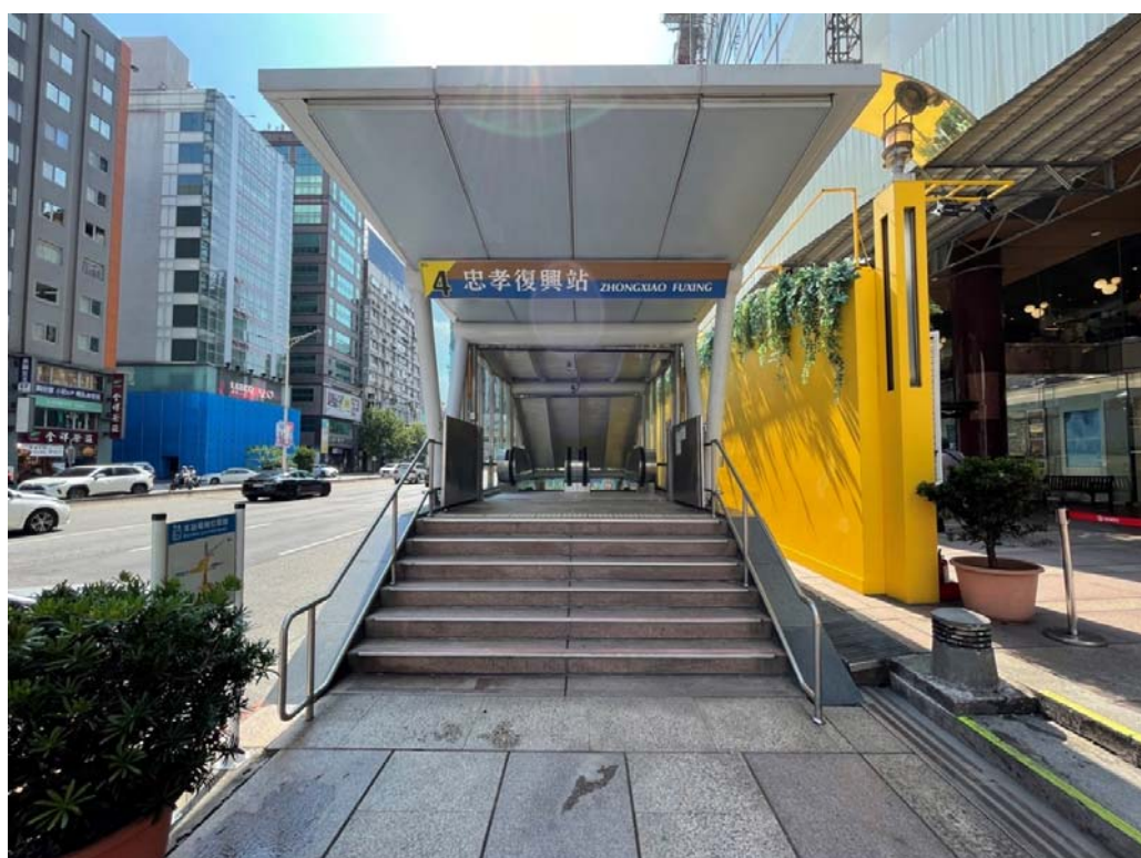
忠孝復興站4號出入口於111年8月15日開放啟用 「捷運初期路網電扶梯/電梯中期改善工程」全數60部電扶梯完成
