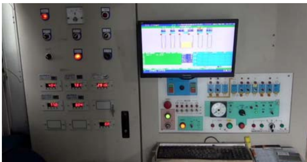
混凝土自動化生產，資料公開、透明
