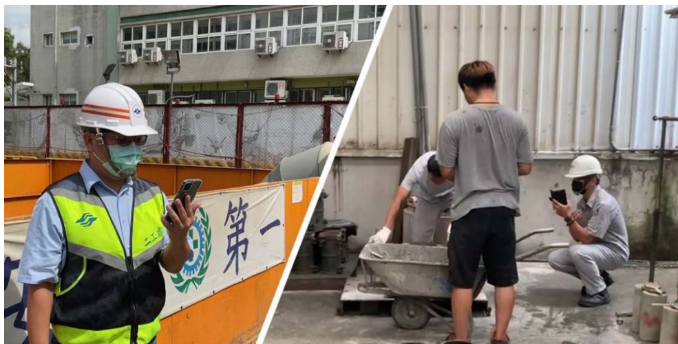
監工人員於臺北工地運用遠端視訊設備，隨時查驗苗栗工廠混凝土生產情形
