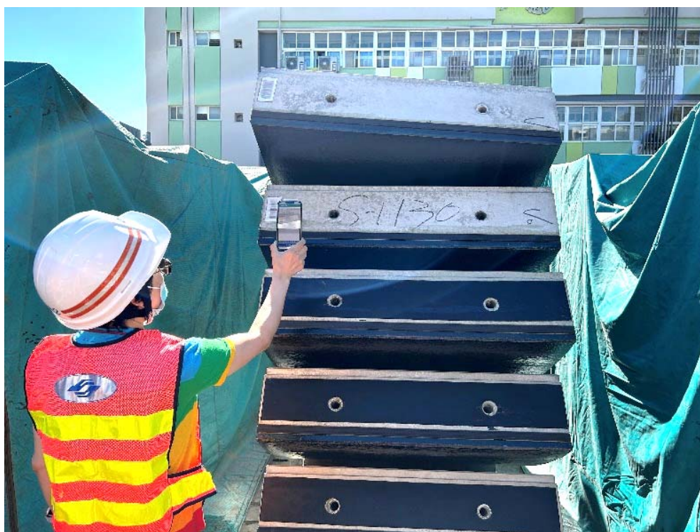
透過手機APP掃描環片條碼，工地品管檢驗迅速簡便
