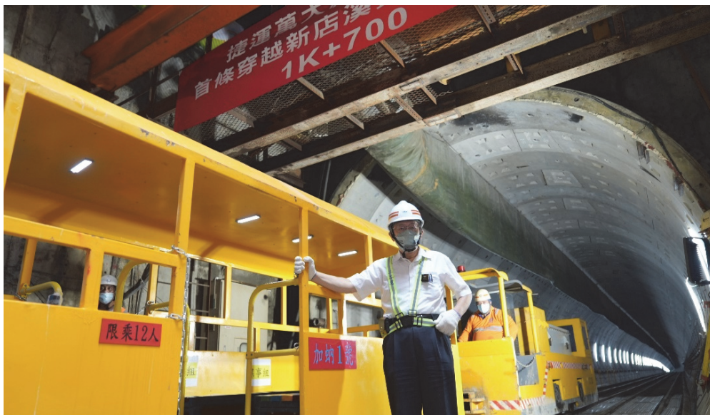
柯市長視察加蚋站穿越新店溪貫通雙河底潛盾隧道(1)
