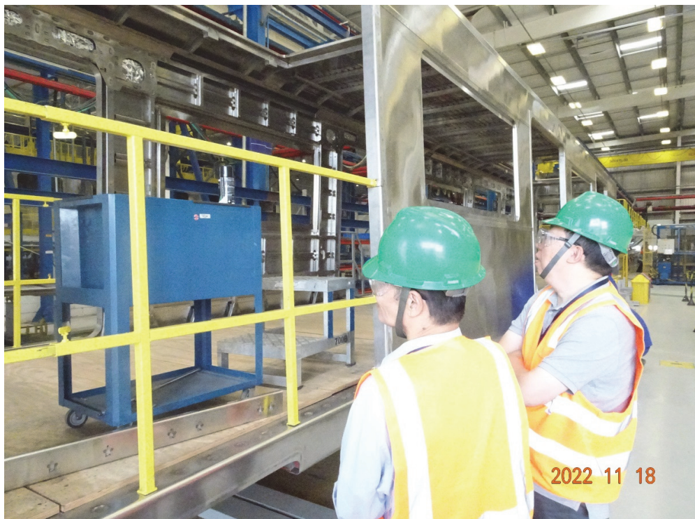
圖1.駐廠監造人員檢查車體組裝狀況
