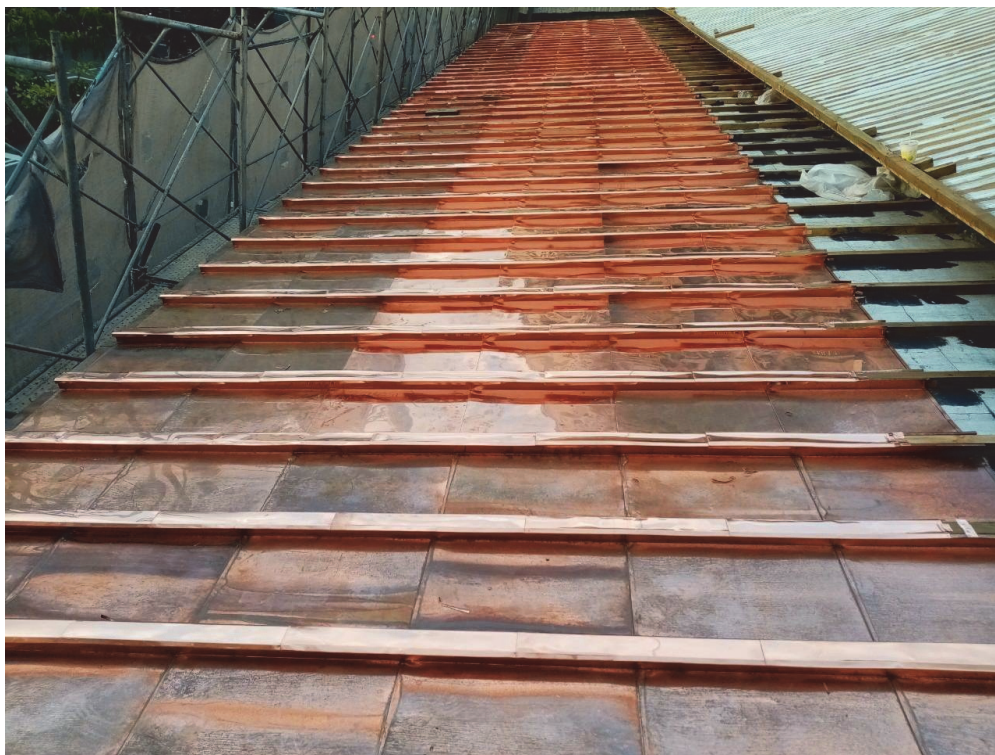
圖6.銅皮瓦棒鋪築
