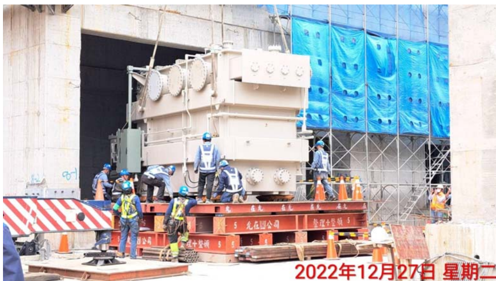
圖一、161kV主變壓器進場
