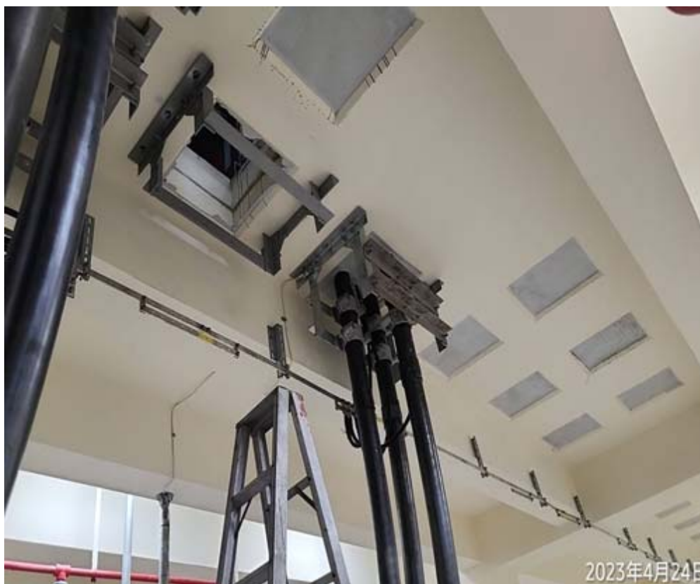
圖三、161kV電纜-台電涵洞支撐架安裝
