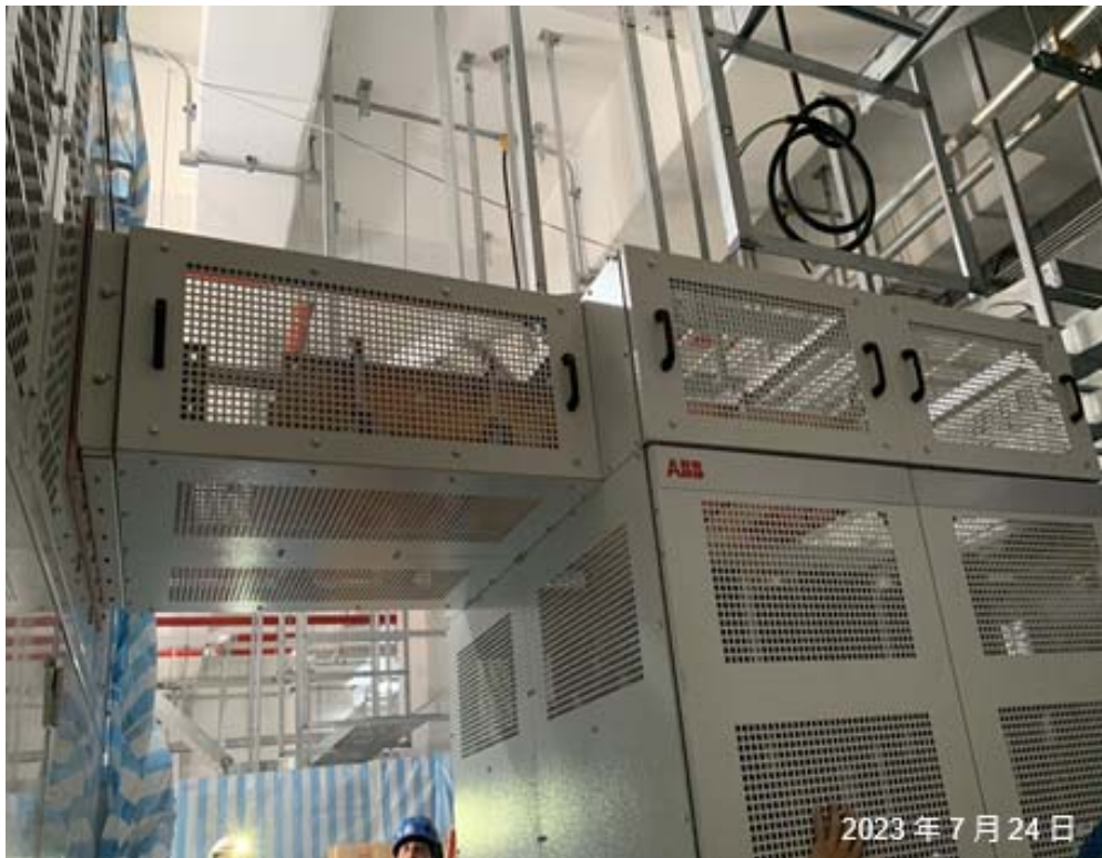
圖五、牽引動力配電室之直流設備安裝作業
