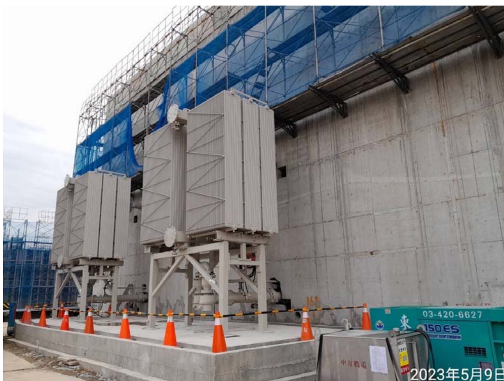
圖四、主變壓散熱器安裝完成
