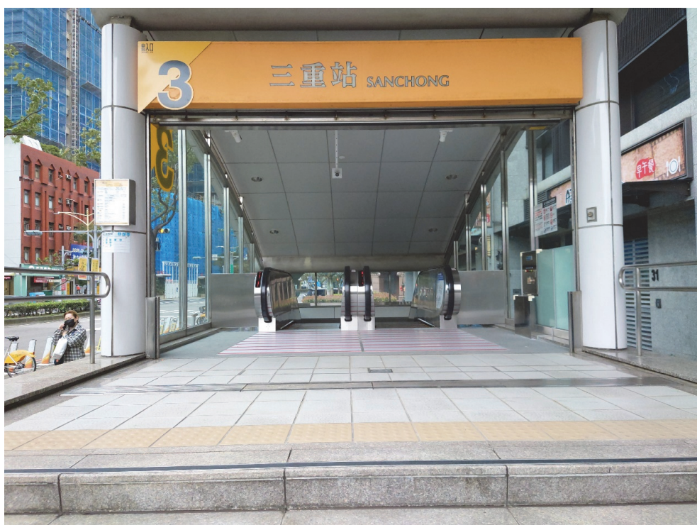
三重站3號出入口雙向電扶梯啟用
