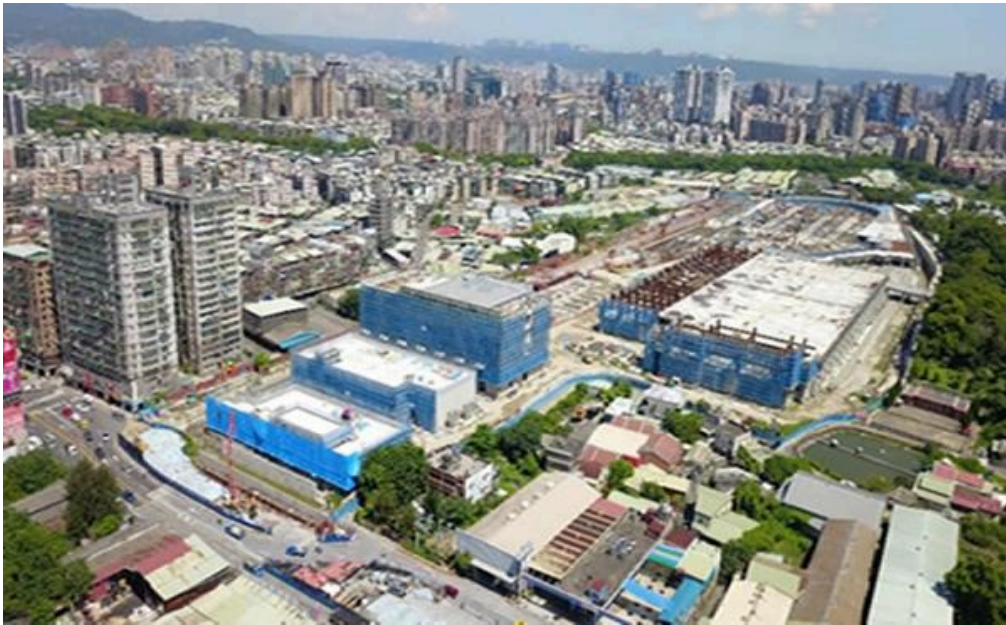
圖1 萬大線CQ870區段標(金城機廠)工程工地
